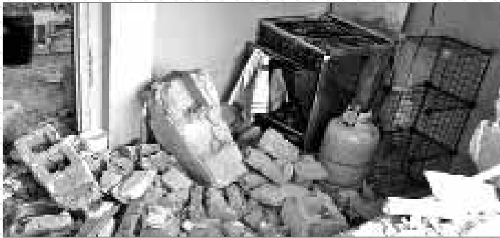
آوار ناشی از ترکیدگی آتیرمکن
